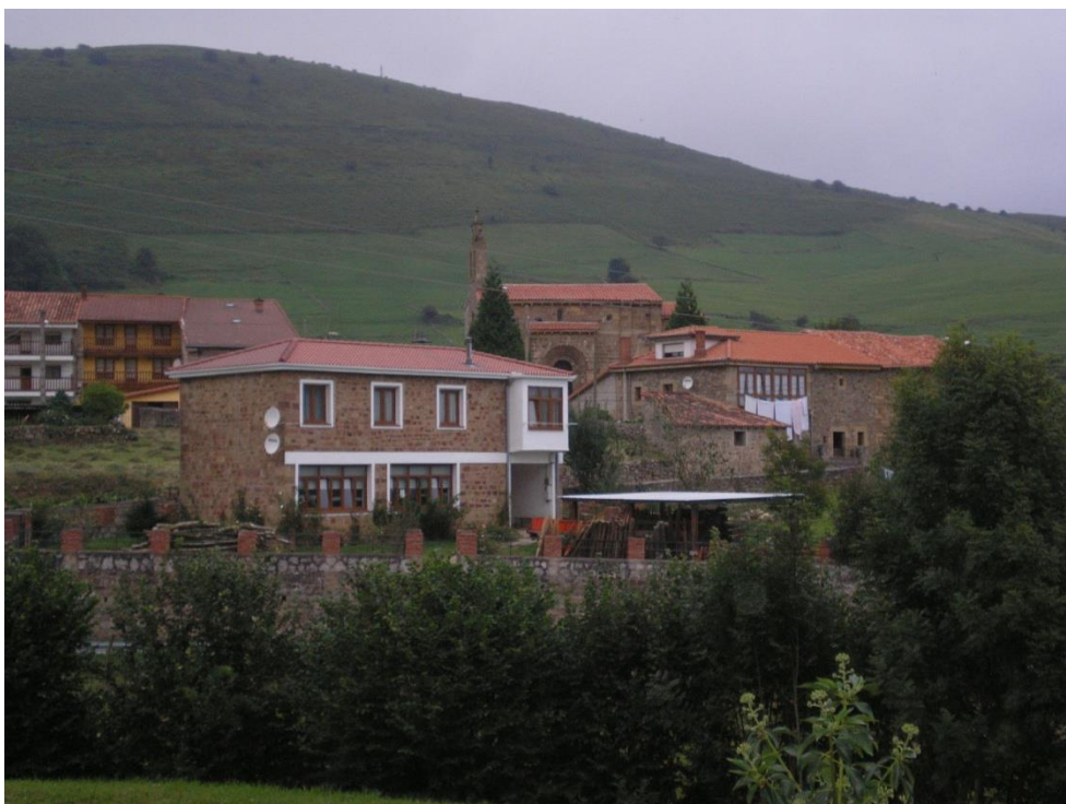
Rehabilitación escuela nueva y adecuación como centro social
