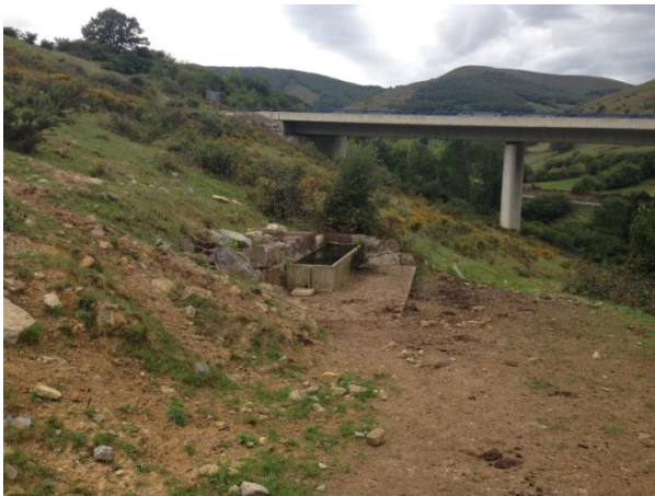
Captación de agua fuente “los Muertos”
