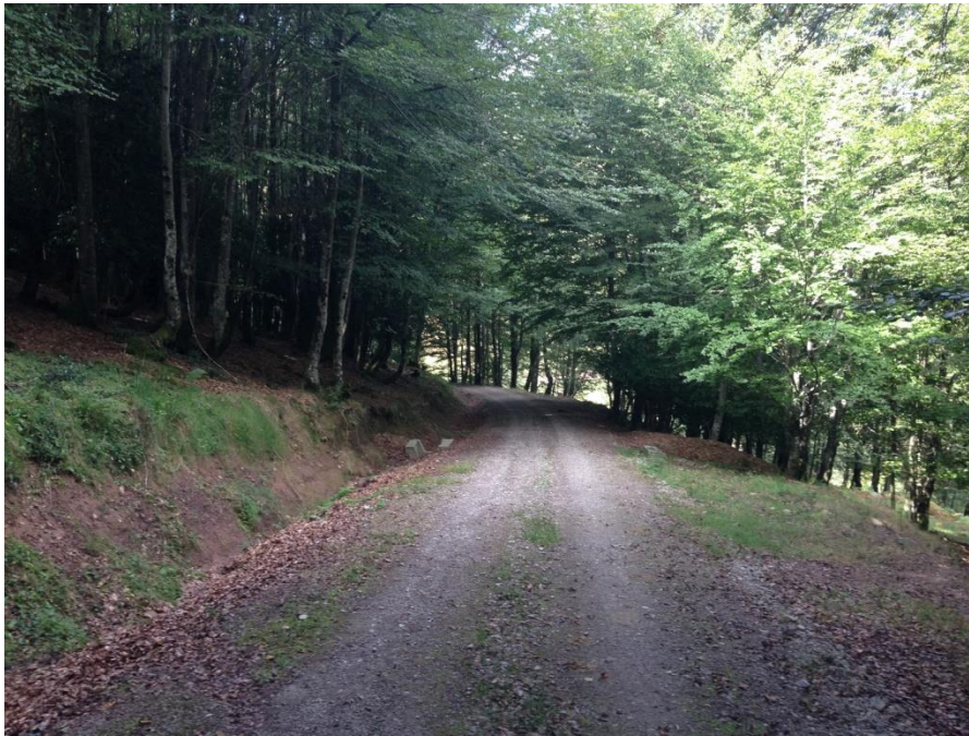
Reparación y saneamiento pista “la Campurriosa” 3.060 metros.
