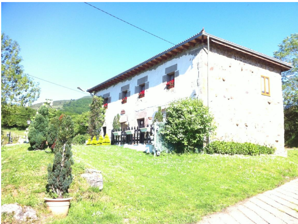
Rehabilitación escuela vieja
