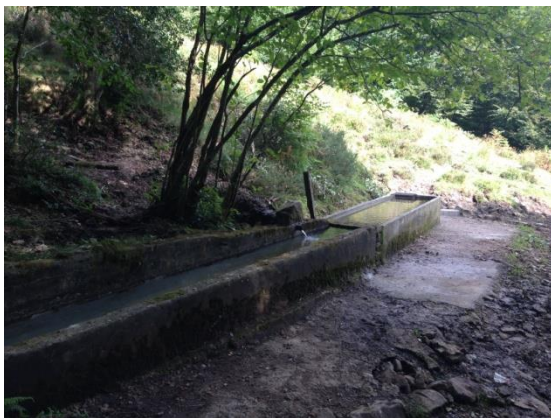
Ampliación abrevadero de 2.000L y mejora de captación fuente “Juan Ruiz”.
